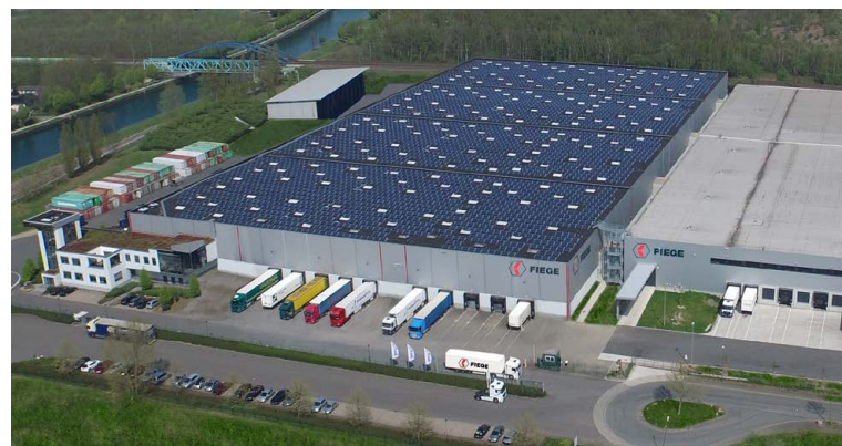
Solarpark Dortmund – Anlageobjekt Zukunftsenergie Deutschland 4
